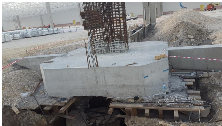
Слика 5.23. Реакционен систем за обезбедување на контра-товар, Е2
