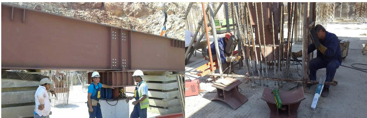
Слика 5.52. Приказ на подготовка на кол тестот, Е4
