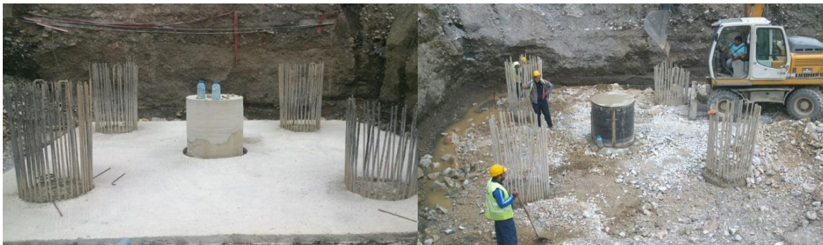
Слика 5.47. Приказ на подготовка на кол тестот, Е3
