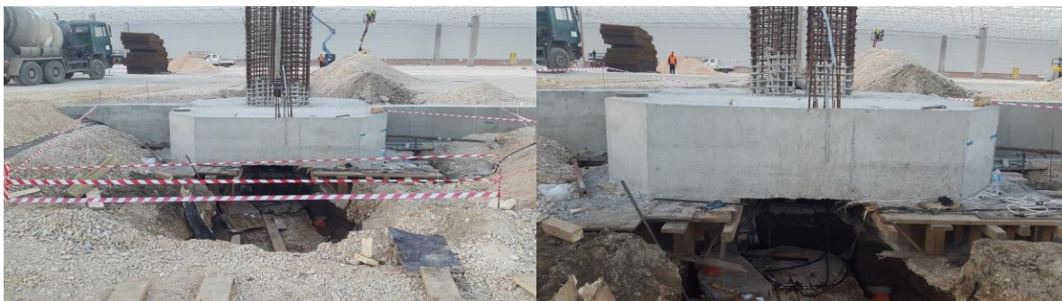
Слика 5.41. Приказ на реакционен систем, E2
