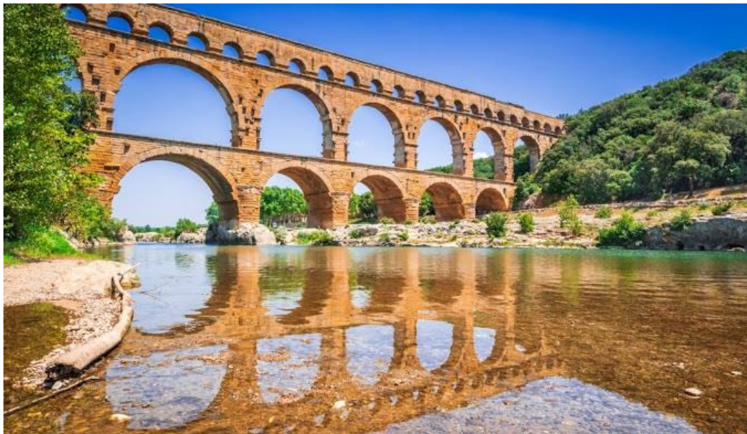
Слика 13 - Најдолгиот аквадукт Pont du Gard, Франција (1 век н.е) (URL7)
