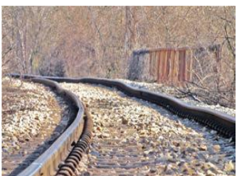
Слика 22. Приказ на лоша геометрија на колосек и репрезентативен дијаграм
