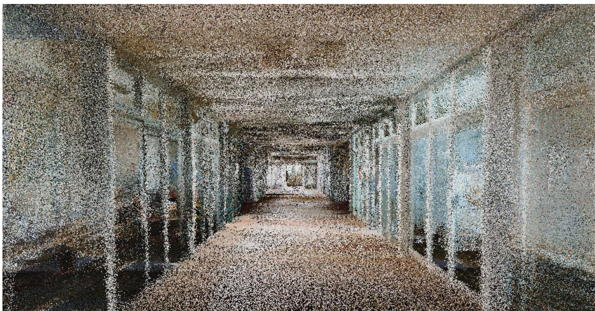
Слика 7.16. Обработен облак од точки од внатрешноста на мост „Влајко“
